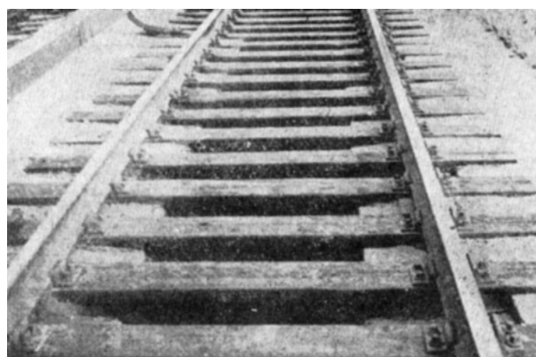
Рис. 15. Путь на жестком основании
