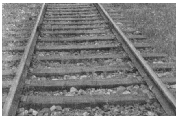
Рис. 14. Путь на упругом основании
